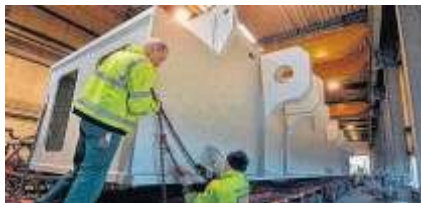
Das Bauteil wird mit schweren Ketten gesichert. FOTO: FRANK GEHRMANN
